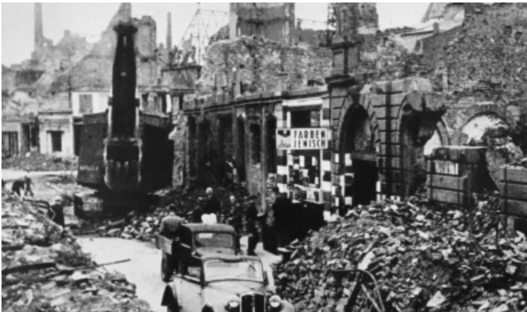
Kriegszerstörung Großer Hirsch- graben 15
