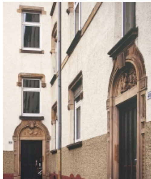
Eingangstür Rohrbachstraße 40 a–b
